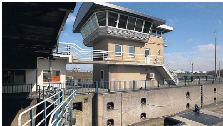
Brug bij de Tjerk Hiddessluizen. FOTO ARCHIEF
